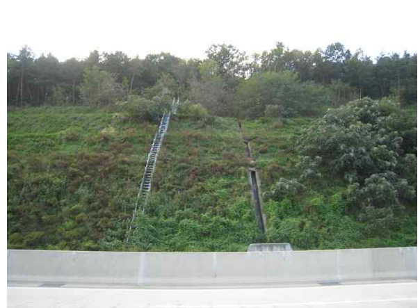
점검계단, 수직도수로 전경
