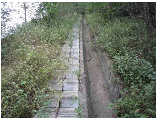
산마루측구, 점검계단 전경
