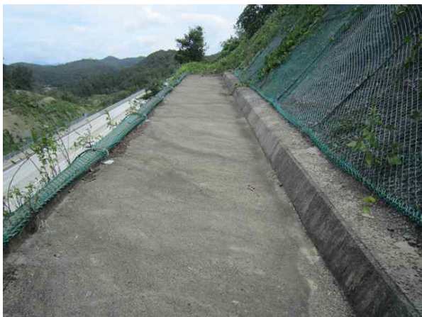
1소단 배수로 전경
