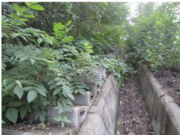
산마루측구, 점검계단 전경
