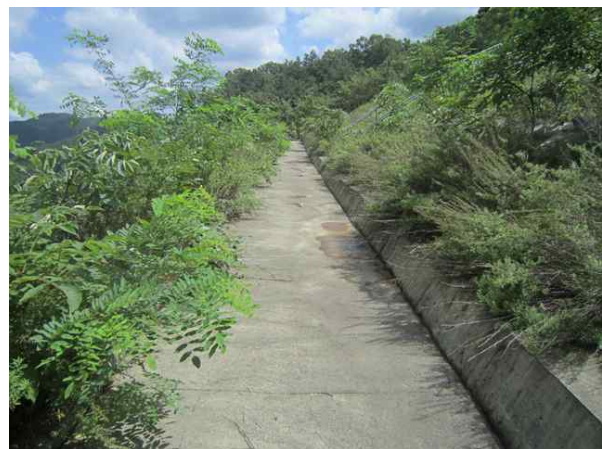
1소단 배수로 전경
