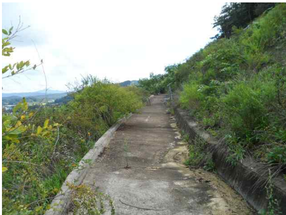
1소단 배수로 전경
