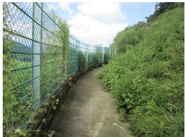
2소단 배수로 전경
