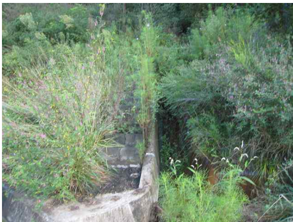
산마루측구, 점검계단 전경
