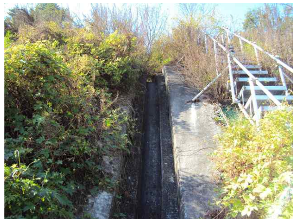
수직도수로, 점검계단 전경
