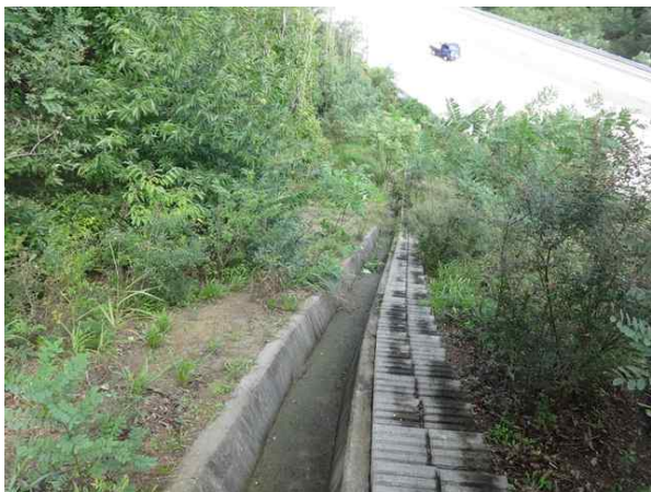
산마루측구, 점검계단 전경
