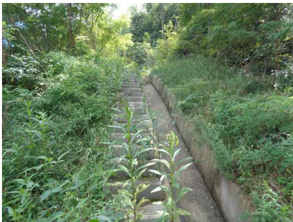
점검계단, 산마루측구 전경
