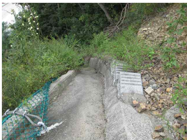
산마루측구, 점검계단 전경
