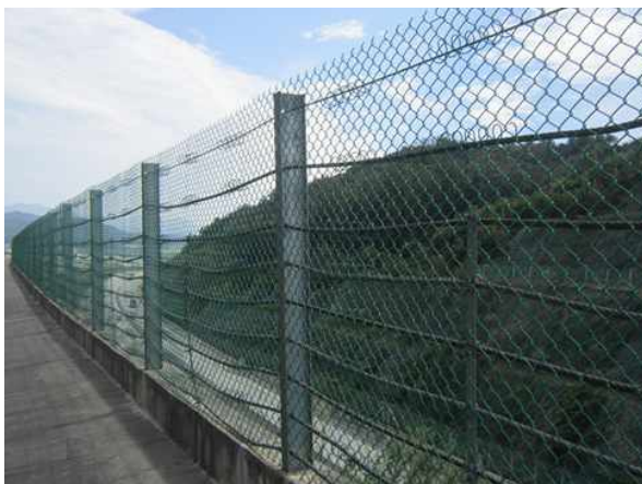
소단배수로 낙석방지울타리 전경
