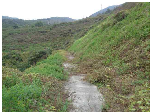
1소단 배수로 전경
