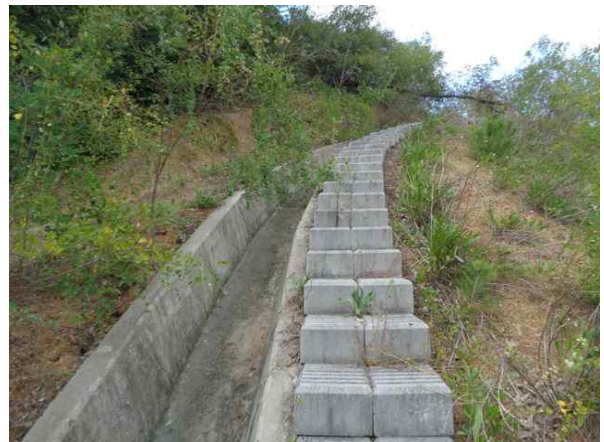
산마루측구, 점검계단 전경
