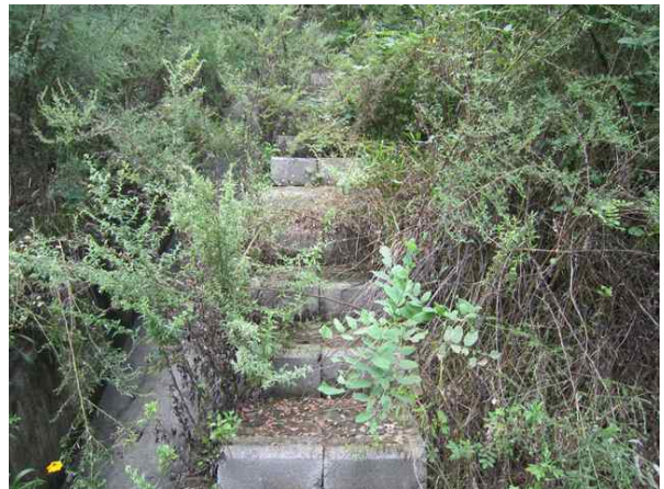
산마루측구, 점검계단 전경
