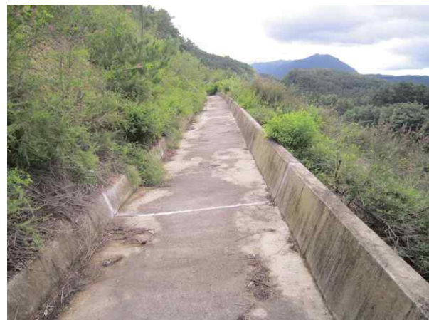
1소단 배수로 전경
