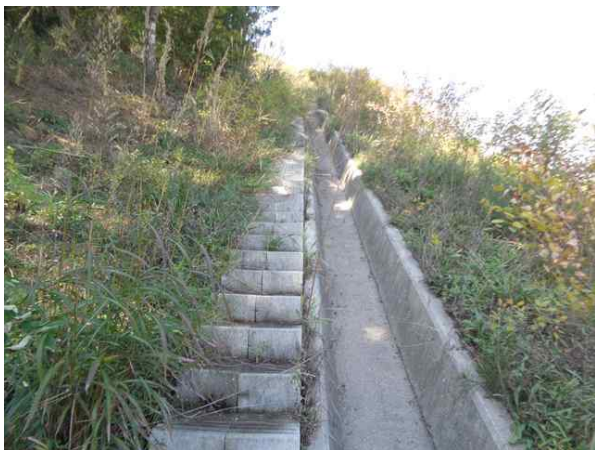
산마루측구, 점검계단 전경
