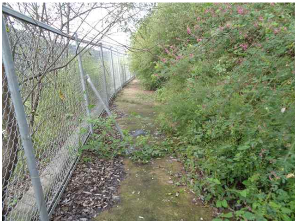
1소단 배수로 전경
