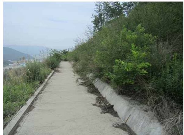
1소단 배수로 전경
