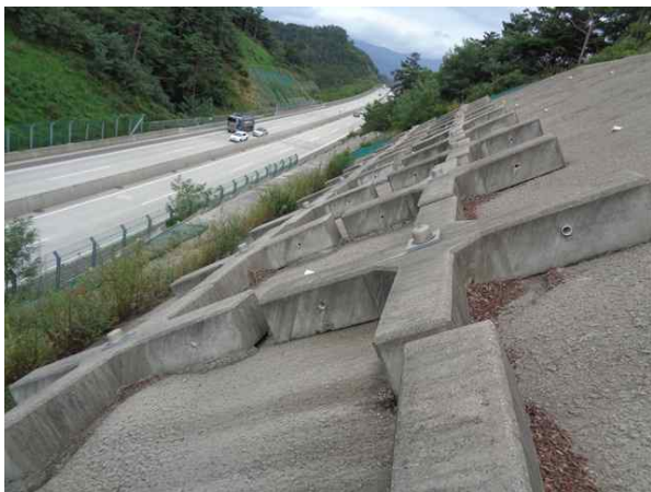
숏크리트, 격자블럭 전경
