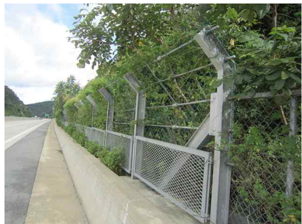
도로, 낙석방지울타리 전경
