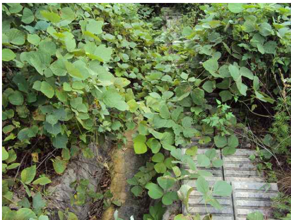
산마루측구, 점검계단 전경
