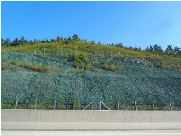
사면 정면 전경
