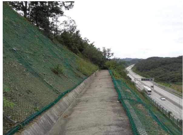
1소단 배수로 전경
