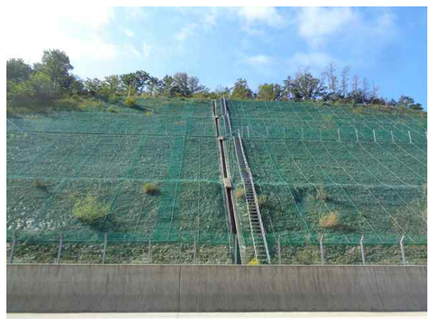
수직도수로, 점검계단 전경
