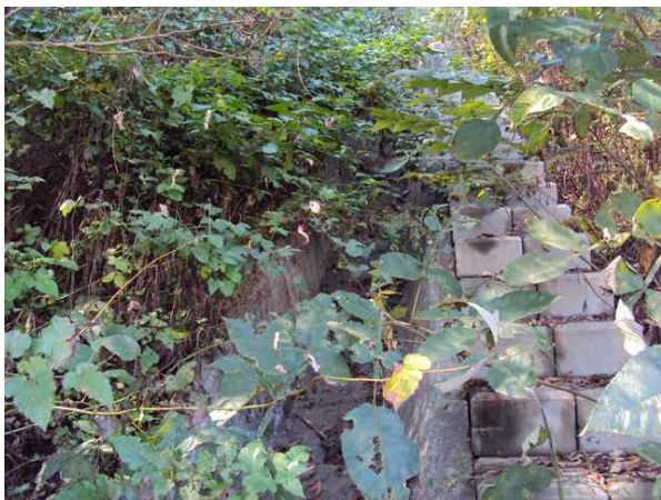
산마루측구, 점검계단 전경
