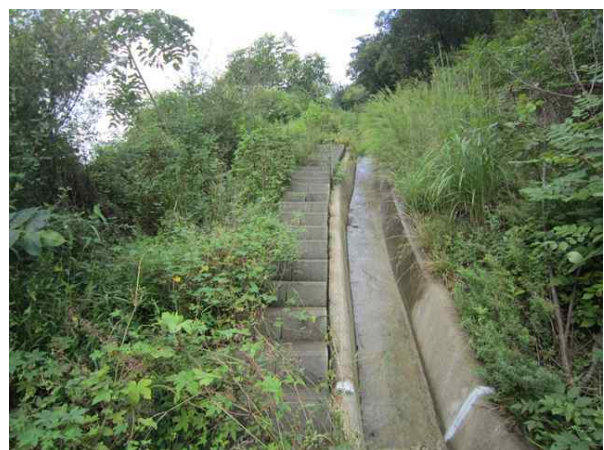
산마루측구, 점검계단 전경
