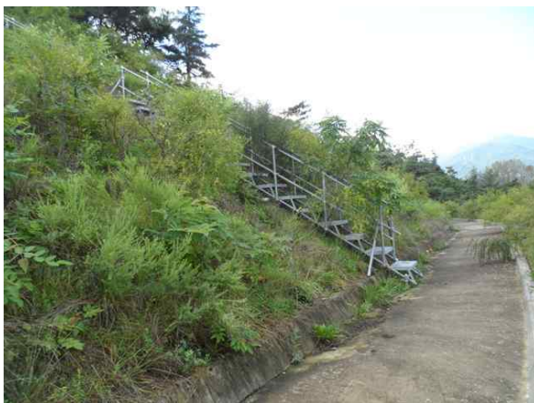
2단 점검계단 전경
