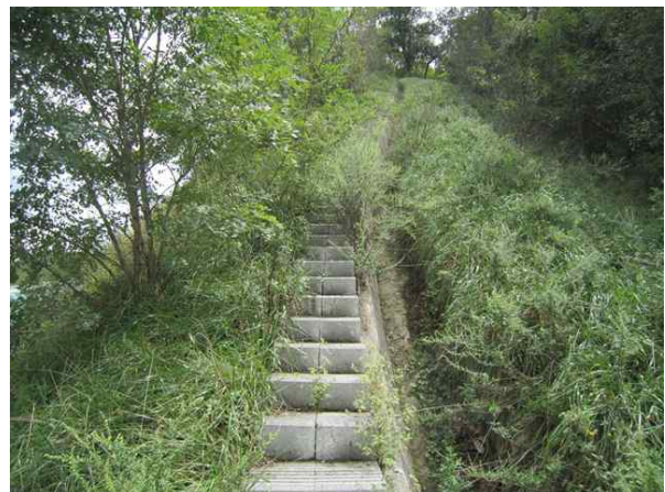
점검계단, 산마루측구 전경
