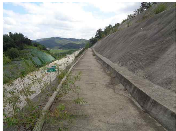
1소단 배수로 전경
