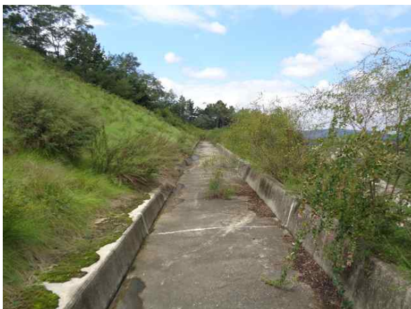
1소단 배수로 전경
