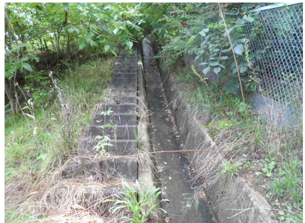
산마루측구, 점검계단 전경
