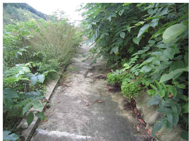
1소단 배수로 전경
