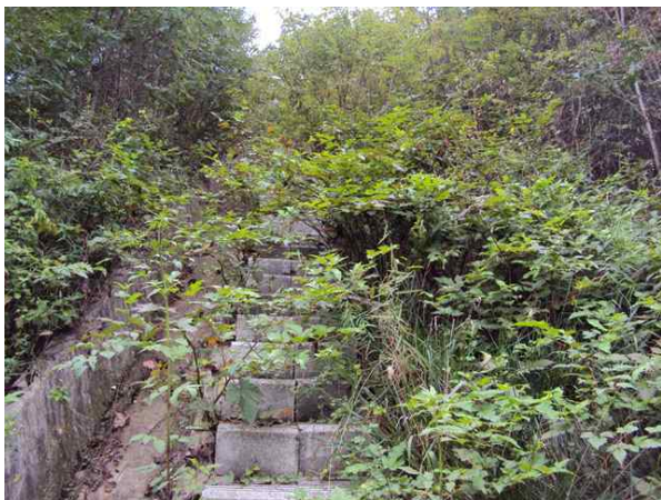
산마루측구, 점검계단 전경
