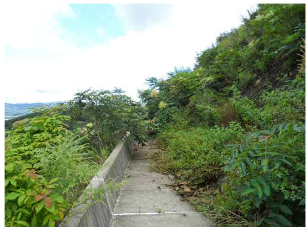
2소단 배수로 전경
