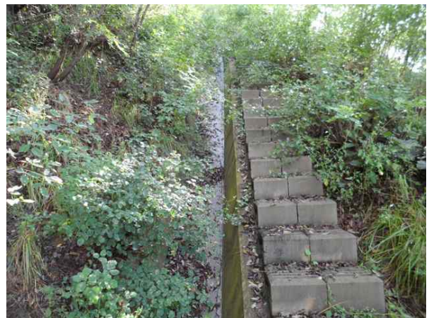
산마루측구, 점검계단 전경
