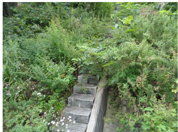
점검계단, 산마루측구 전경
