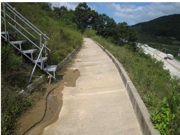
1소단 배수로 전경
