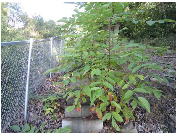
점검계단, 산마루측구 전경
