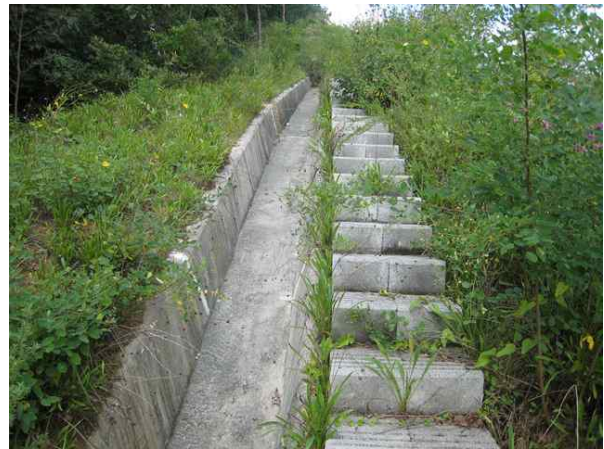
산마루측구, 점검계단 전경
