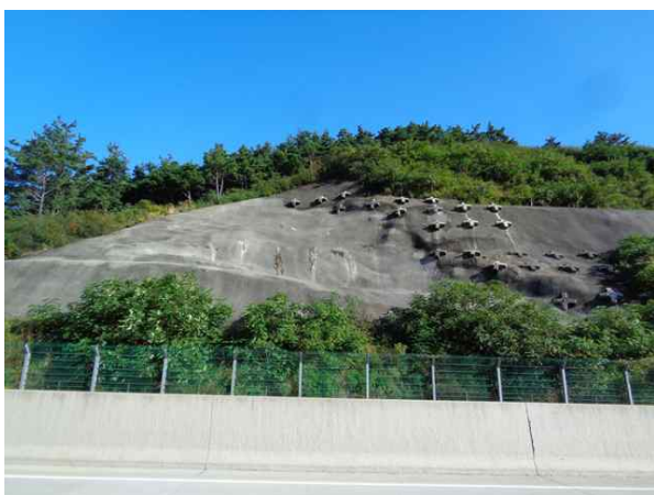
-shotcrete, 격자블럭 전경
