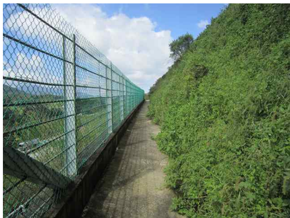
1소단 배수로 전경
