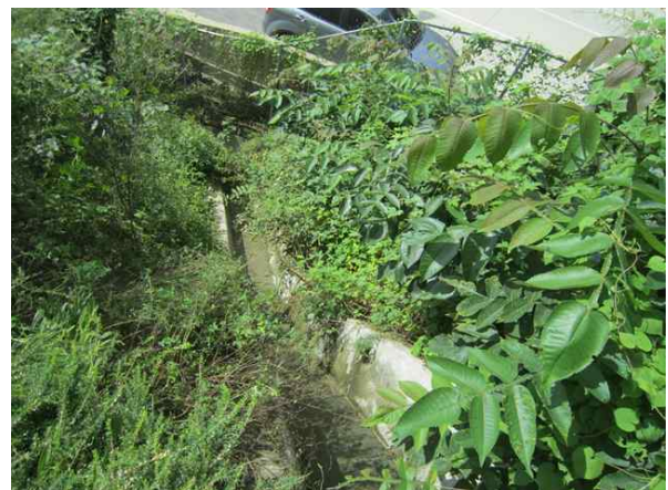
2소단 배수로 전경
