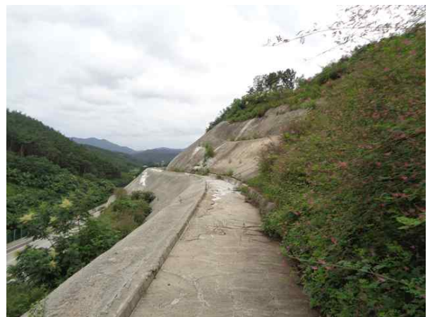
1소단 배수로 전경
