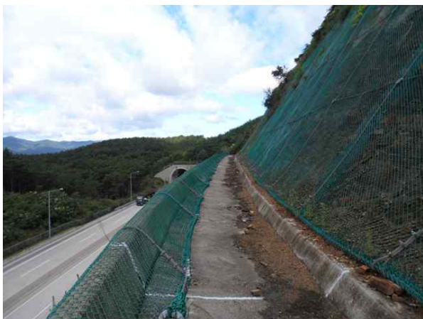
1소단 배수로 전경
