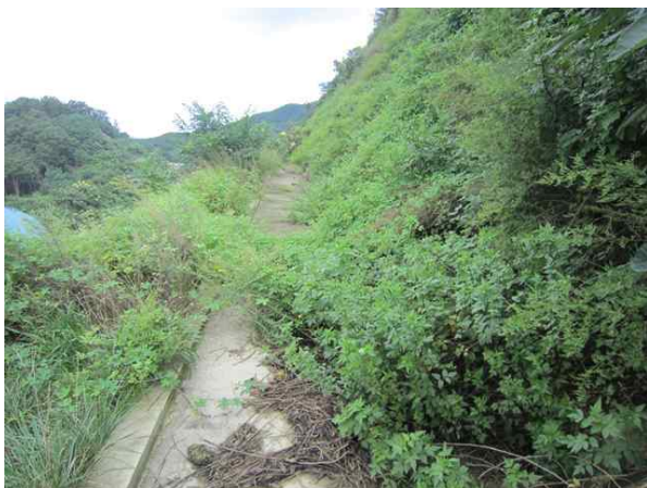
1소단 배수로 전경
