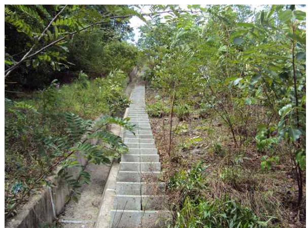
산마루측구, 점검계단 전경
