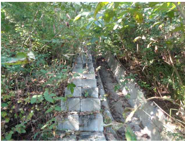
산마루측구, 점검계단 전경
