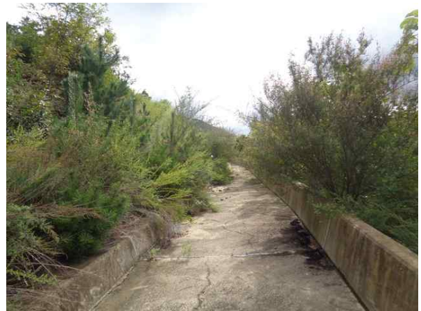
1소단 배수로 전경
