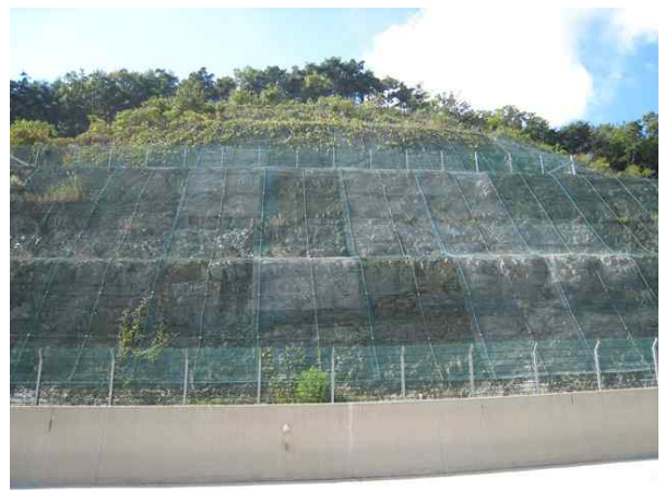
낙석방지망, 낙석방지울타리 전경
