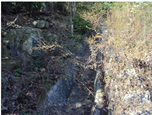
산마루측구, 점검계단 전경
