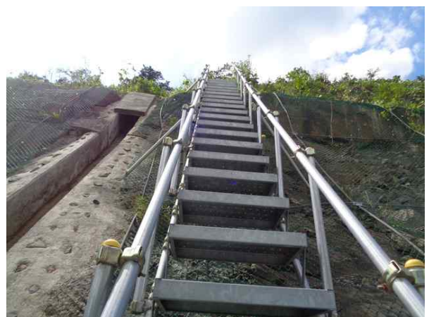
수직도수로, 점검계단 전경
