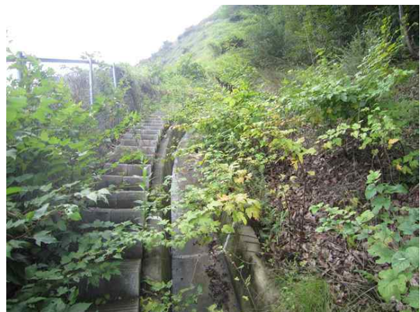
산마루측구, 점검계단 전경
