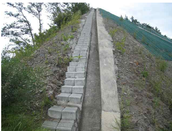
산마루측구, 점검계단 전경
