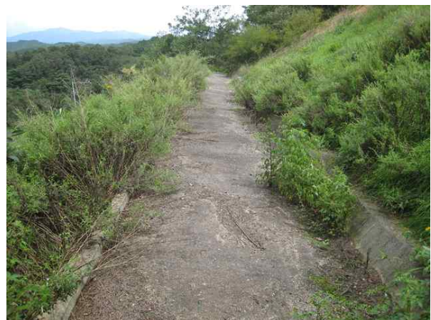
1소단 배수로 전경
