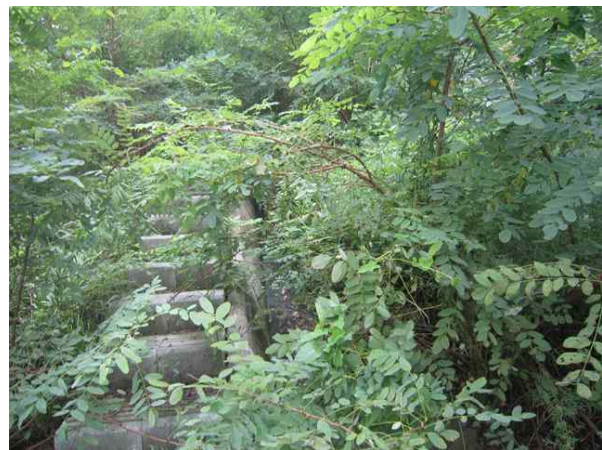
산마루측구, 점검계단 전경
