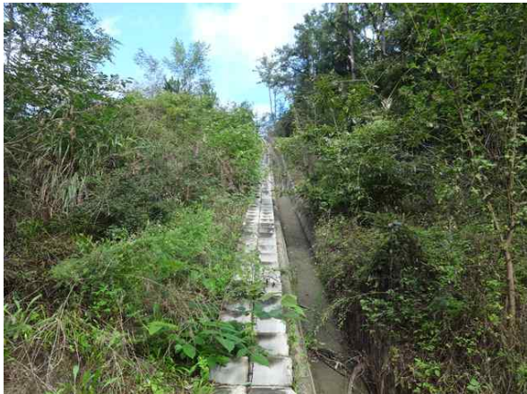
산마루측구, 점검계단 전경
