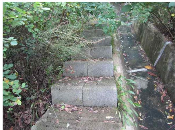
산마루측구, 점점계단 전경
