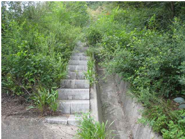
산마루측구, 점검계단 전경
