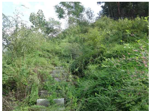
점검계단, 산마루측구 전경
