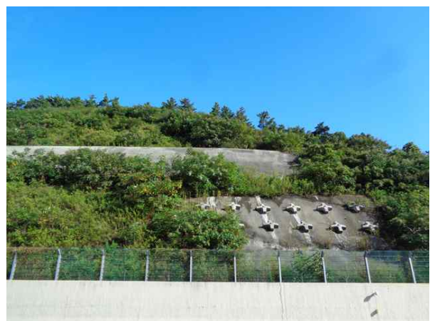
-shotcrete, 격자블럭 전경
