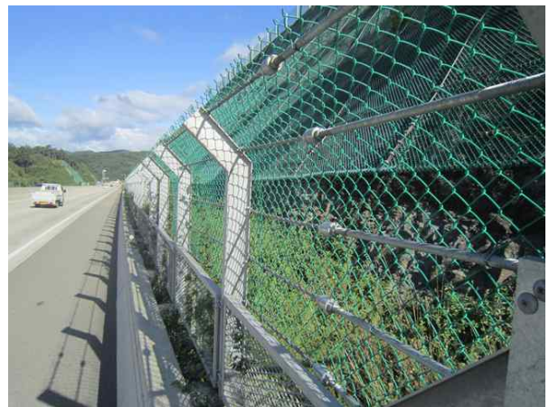
도로, 낙석방지울타리 전경
