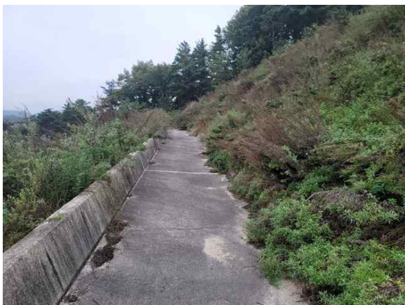
1소단 배수로 전경
