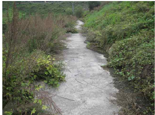
1소단 배수로 전경
